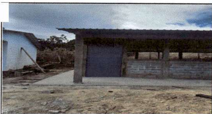
Foto 5: Sustitución de puerta en modulo 2 de cocina.
