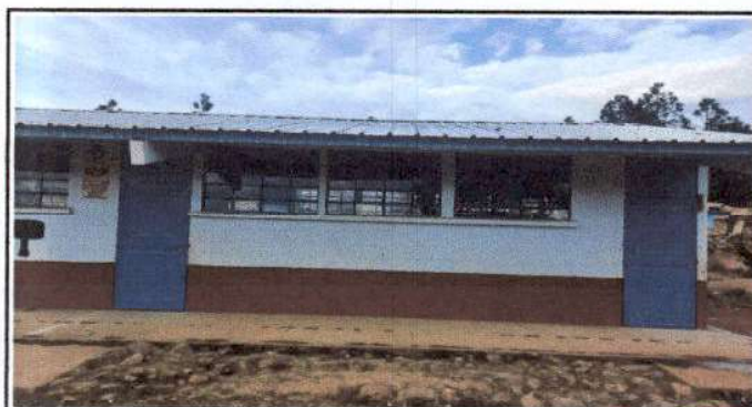
Foto 3: Sustitución de puertas en modulo 1 de aulas.
