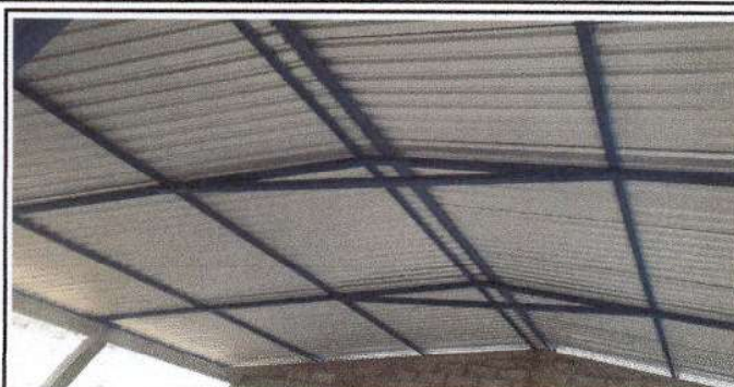
Foto 2: Sustitución de estructura de soporte de metal, por metal en modulo 2 de cocina.
