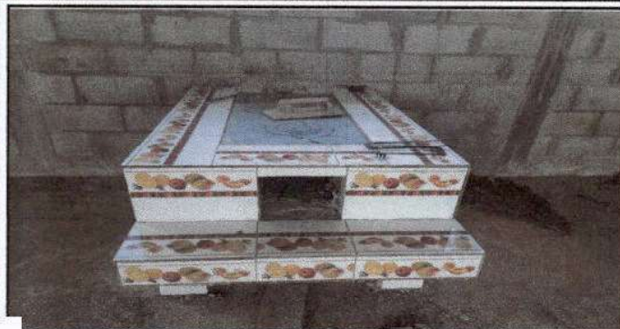
Foto7: Sustitución de estufa rural en modulo 2 de cocina.
