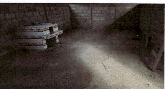
Foto 6: sustitución de piso líquido de cemento en modulo 2 de cocina.
