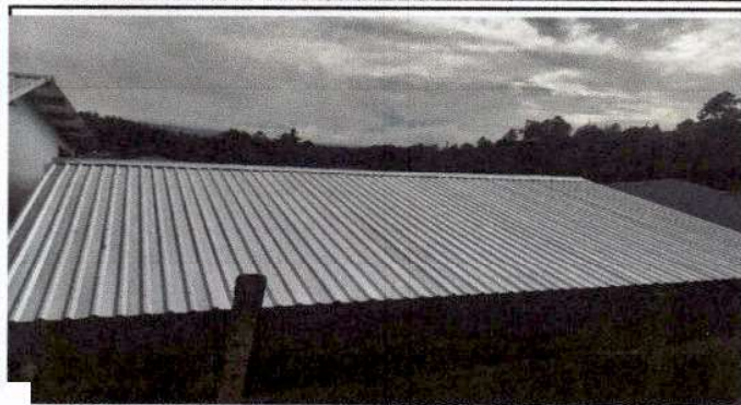
Foto 1: Sustitución de lámina, por lámina troquelada en modulo 3 de aulas.
